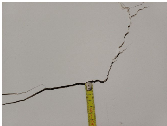
Fisura inclinada a 45 ° sobre dintel de la puerta de entrada a aseo masculino.
