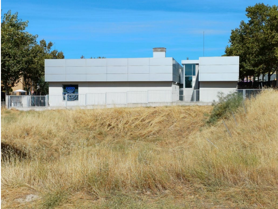
Vista lateral del edificio desde el solar adyacente.
