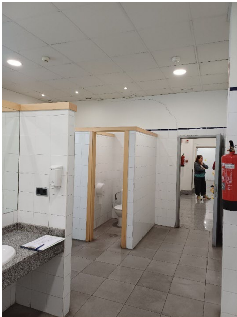
Fisura en horizontal sobre dintel puerta entrada aseo femenino y su continuación en el tabique a 45 grados.
