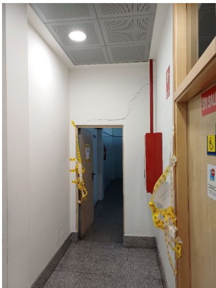
Fisura inclinada a 45 ° sobre dintel de la puerta de entrada a aseo masculino.
