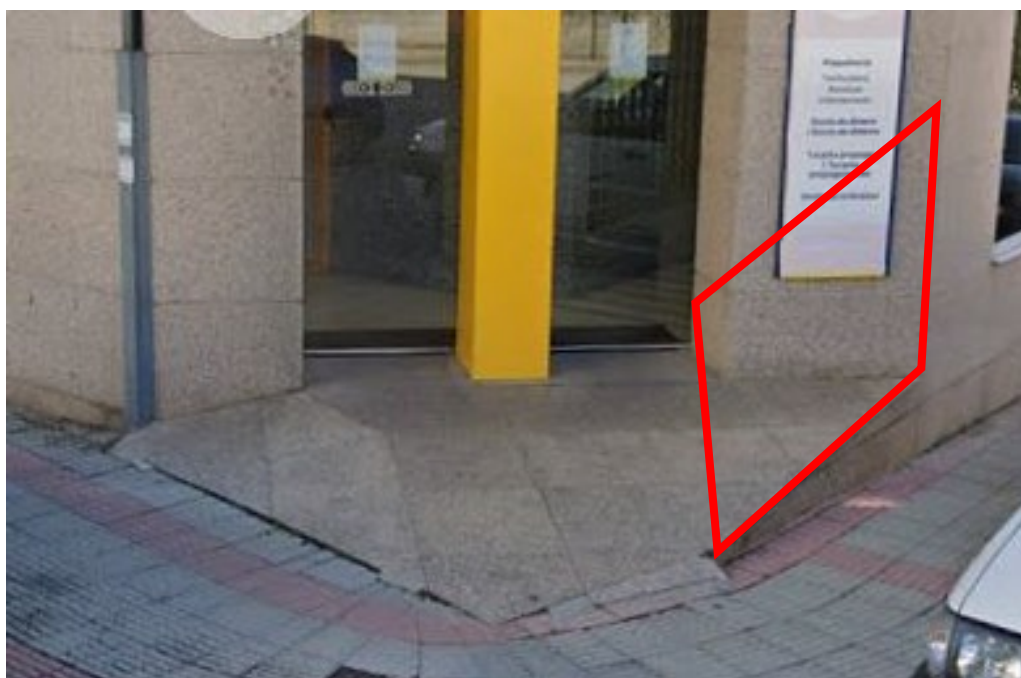
Zona donde instalar la barandilla.
