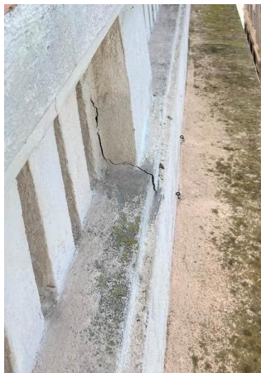
Detalle de falta de goterón hacia fachada exterior en las albardillas de petos.
