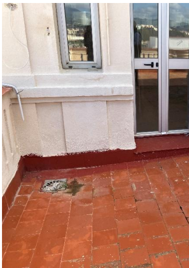
Detalle de piezas de zócalo levantadas y lámina impermeable
