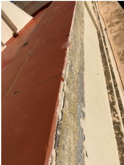
Detalle de falta de goterón hacia fachada exterior en las albardillas de petos.
