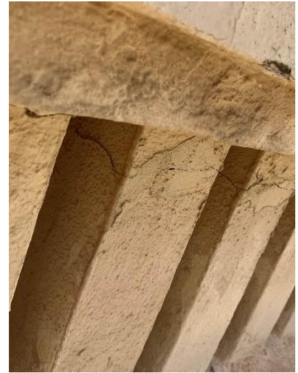
Junta dilatación con pérdida de sellado
