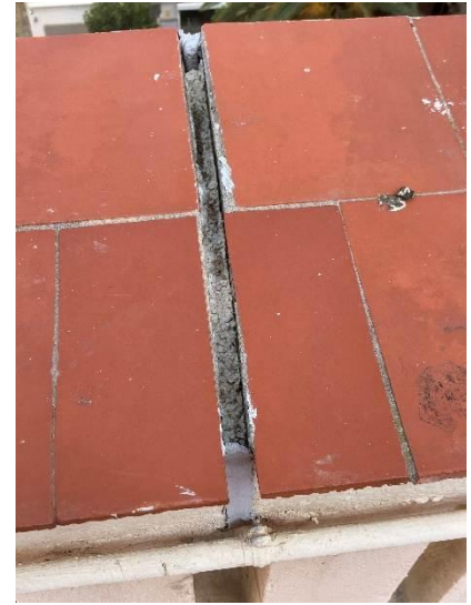
Junta dilatación con pérdida de sellado
