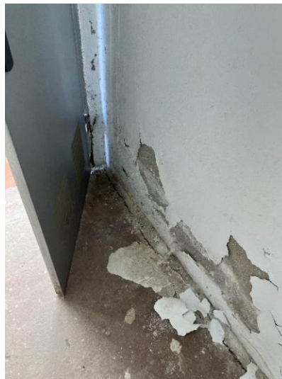
Detalle de piezas de zócalo levantadas y lámina impermeable
