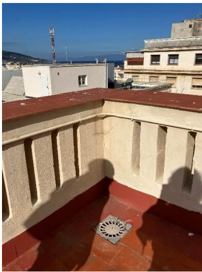
Detalle de fisuración de la balastrada de cubierta
