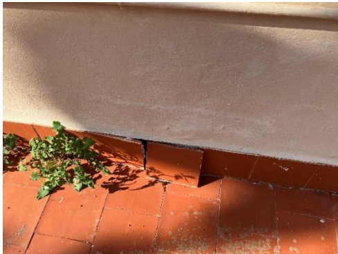
Detalle de piezas de zócalo levantadas y lámina impermeable rígida
