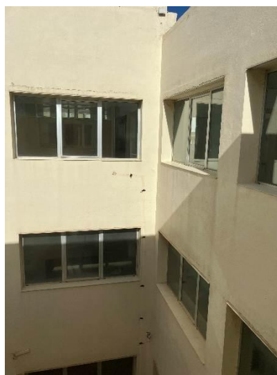
Detalle de fisuración del mortero de revestimiento de patio interior en dinteles de ventanas
