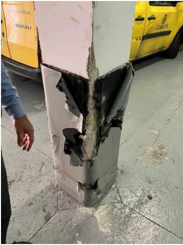
Detalle de pilares golpeados en planta baja (garaje)
