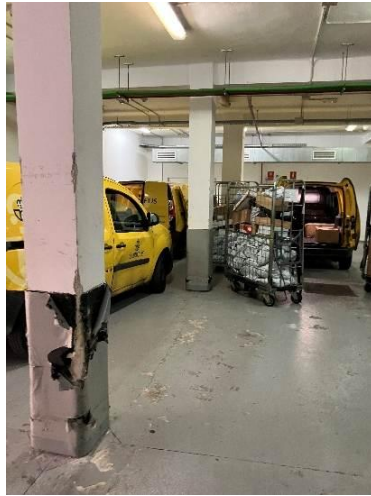
Detalle de pilares golpeados en planta baja (garaje)
