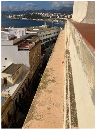
Detalle de falta de goterón hacia fachada exterior en las albardillas de petos.
